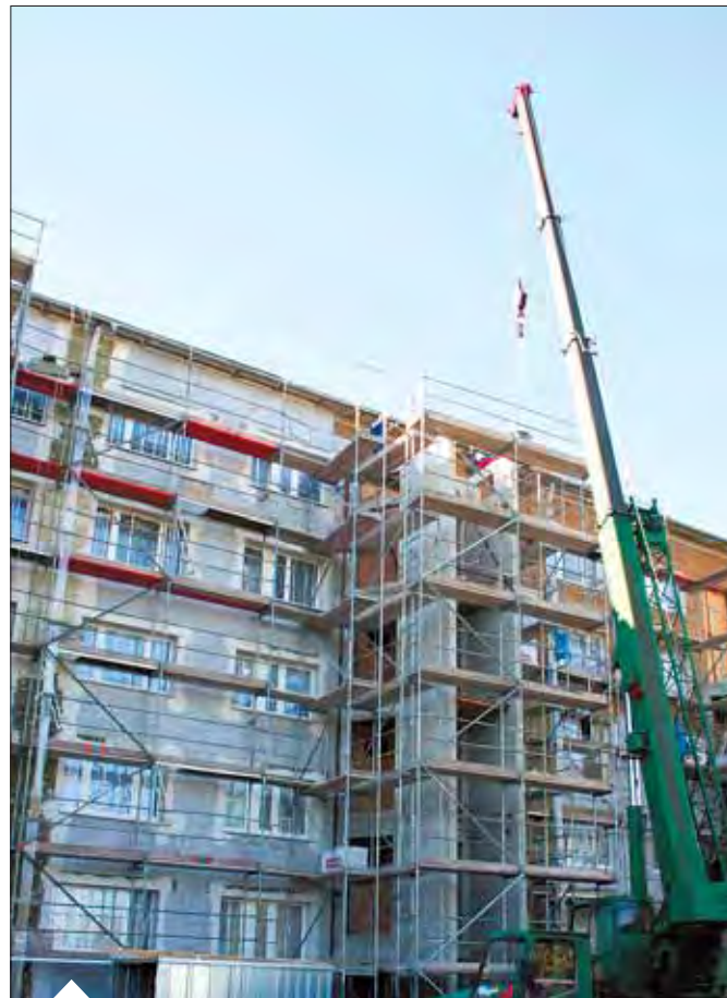
Die wärmedämmende Verkleidung und die neuen Aufzüge sorgen für geringere Kosten und höheren Wohnkomfort in den Wohnungen der WBG.
